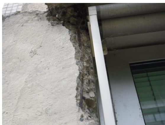
Poteau 9 - éclats et acier vertical apparent
