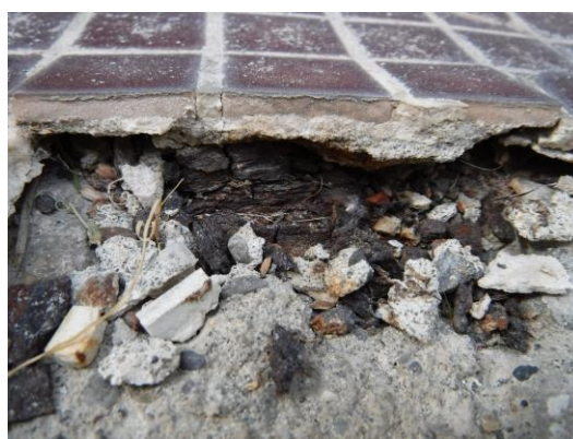
Soubassement préfabriqué – éclats au niveau des ancres
